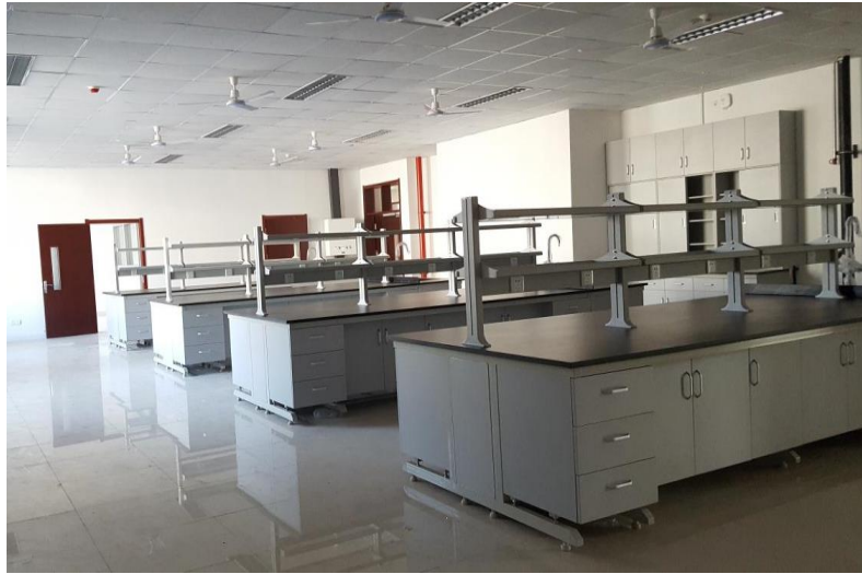
图 1 科研实验室部分实验台已安装完毕
